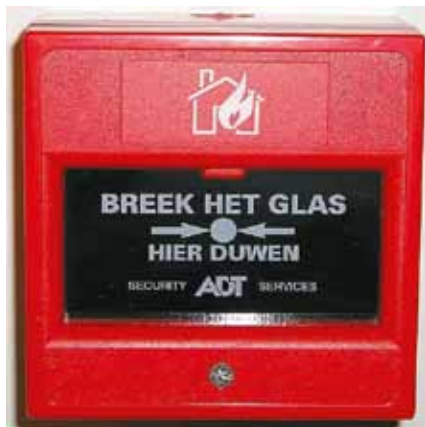
Handmeldinginstallatie: bij brand moet, na het breken van het glas, op een knop worden gedrukt om het brandalarm in werking te stellen
