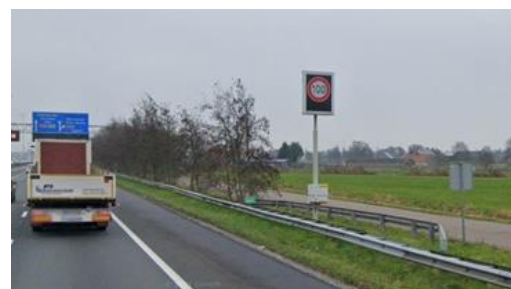
Figuur 3: Snelheidslimietbord tussen stroomweg en erftoegangsweg
